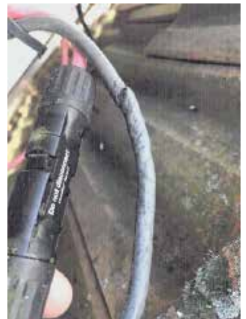
Beschädigte Kabel, zum Beispiel durch Marderfraß (unten), mindern die Leistung und können im Extremfall die ganze Fotovoltaikanlage in Brand setzen. | Fotos: Envaris GmbH
